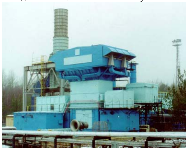
Рис. 1 КВОУ для газоперекачивающего агрегата ГПА-16 «Нева». Первая ступень – прямоточные мультициклоны, вторая ступень – карманные фильтры. 1990-е годы, ОАО «ВНИИтрансмаш».
